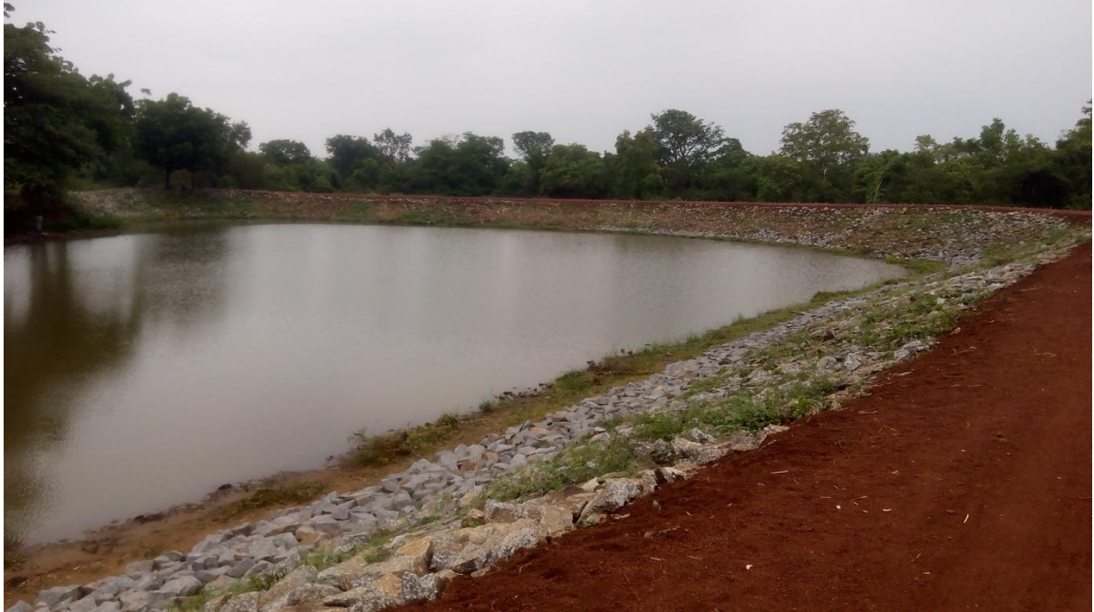
Retenue d'eau réalisée dans le cadre du Projet d'Appui aux Filières Lait et Viande (PAFILAV)
