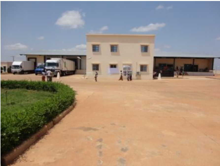
Infrastructure de conditionnement pour PCDA
