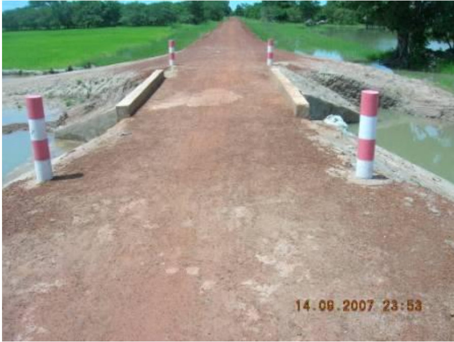
Ouvrage franchissement et aménagement à Kéniégué
