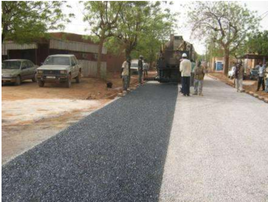
Bitumage de voiries
