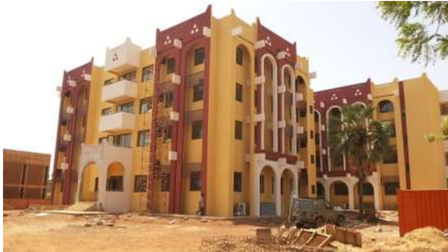
Immeuble administratif Ministère de la Santé
