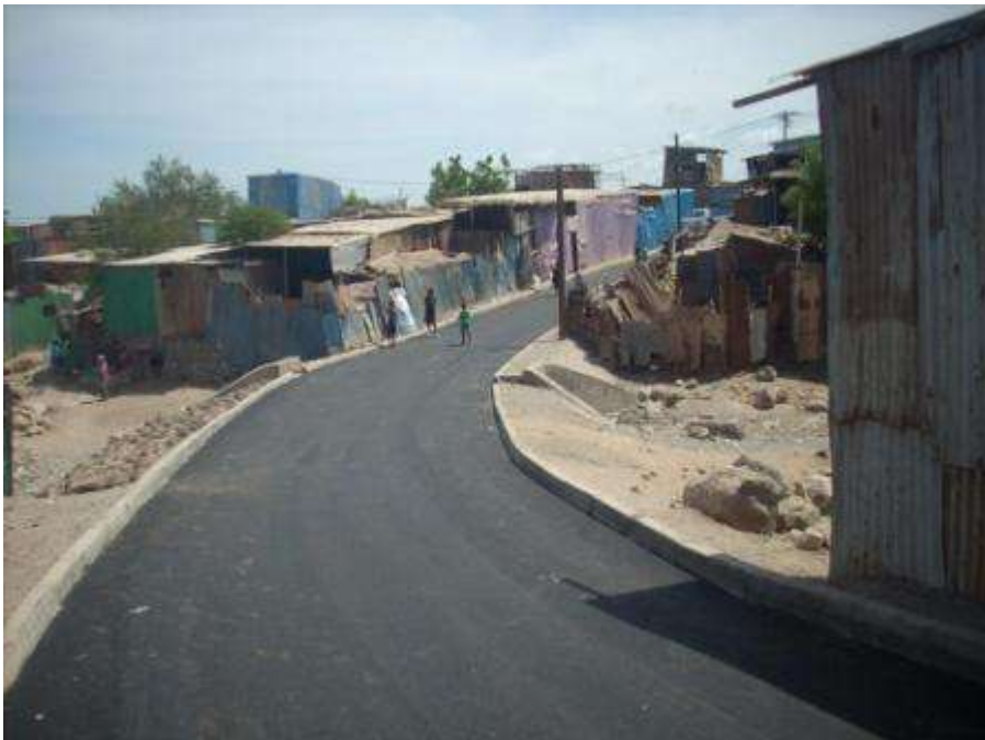
Voie en bitume
