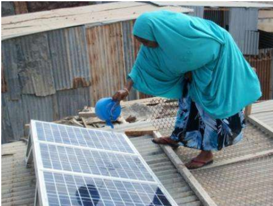
Entretien de panneau solaire domestique
