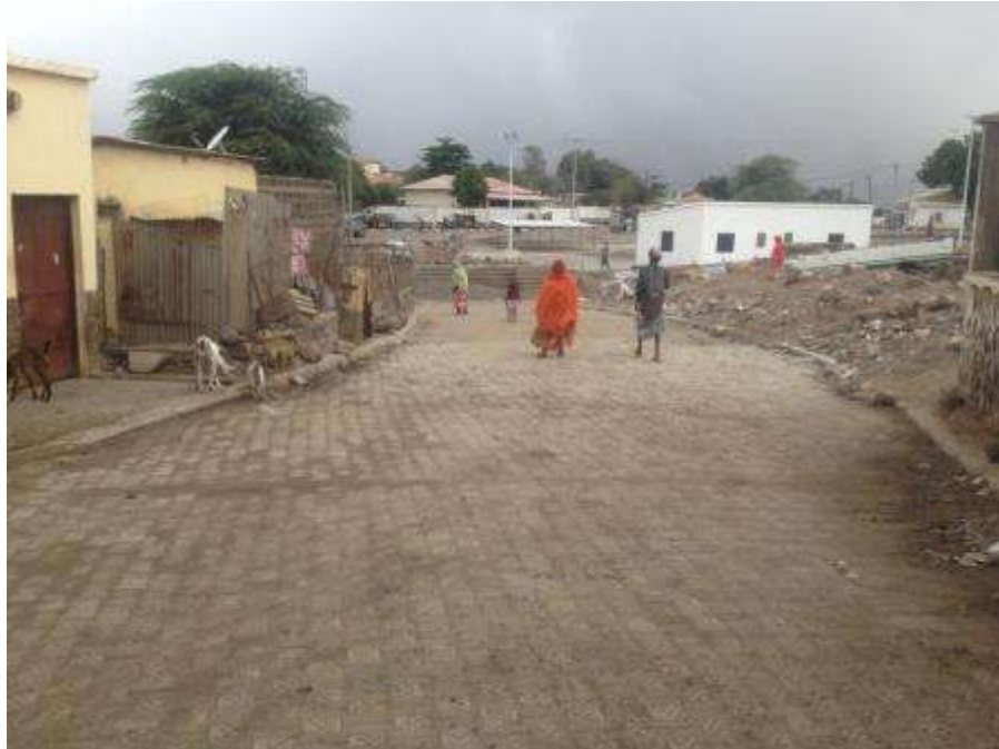
Voie en pavés autobloquants à Arta
