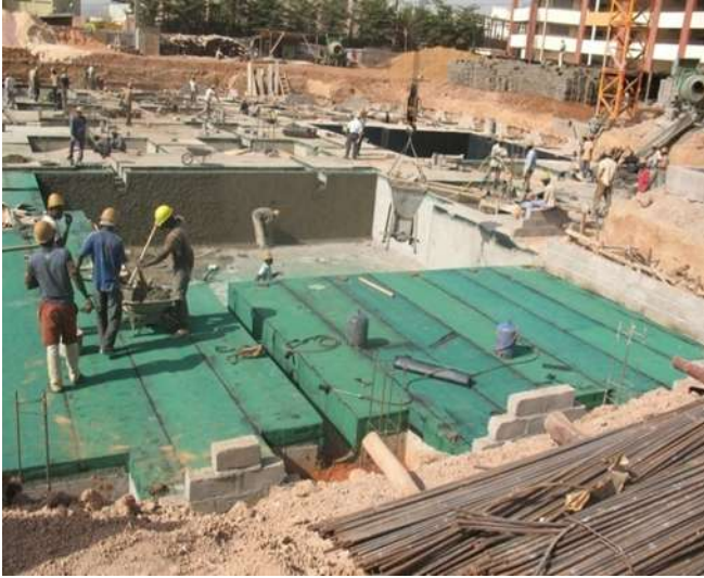
BMS Pose de l'étanchéité
