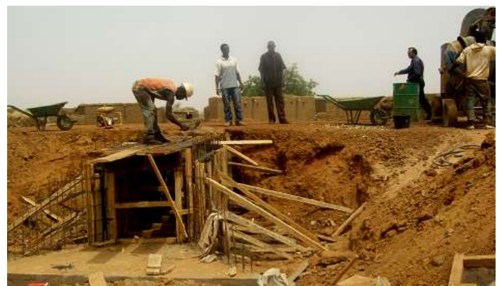
Coulage en cou du béton pour dalle et piédroits
