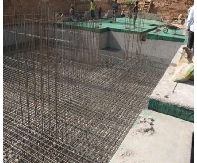
Ferrailage d'une gaine d'ascenseur
