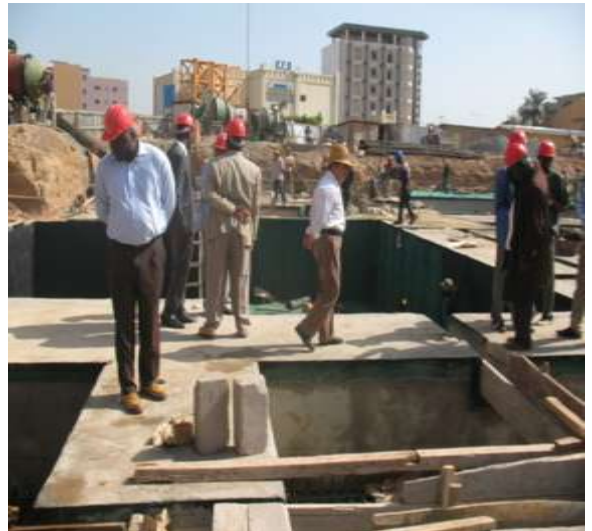
BMS Pose de l'étanchéité
