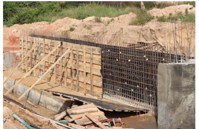
Ouvrage de franchissement
