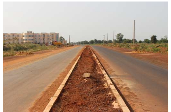
Voie d'accès à la Cité Universitaire de 4000 places de Kabala
