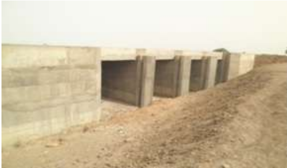
OUVRAGE DE FRANCHISSEMENT NIONO NARA
