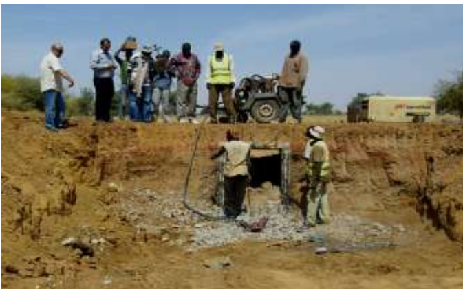
Démolition en cours d'une tête de dalot 1x1x1
