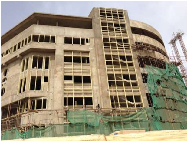
Banque Malienne de Solidarité Façade principale
