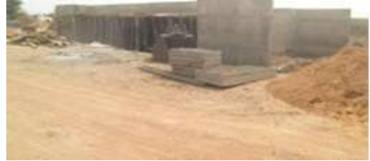
OUVRAGE DE FRANCHISSEMENT NIONO NARA 2
